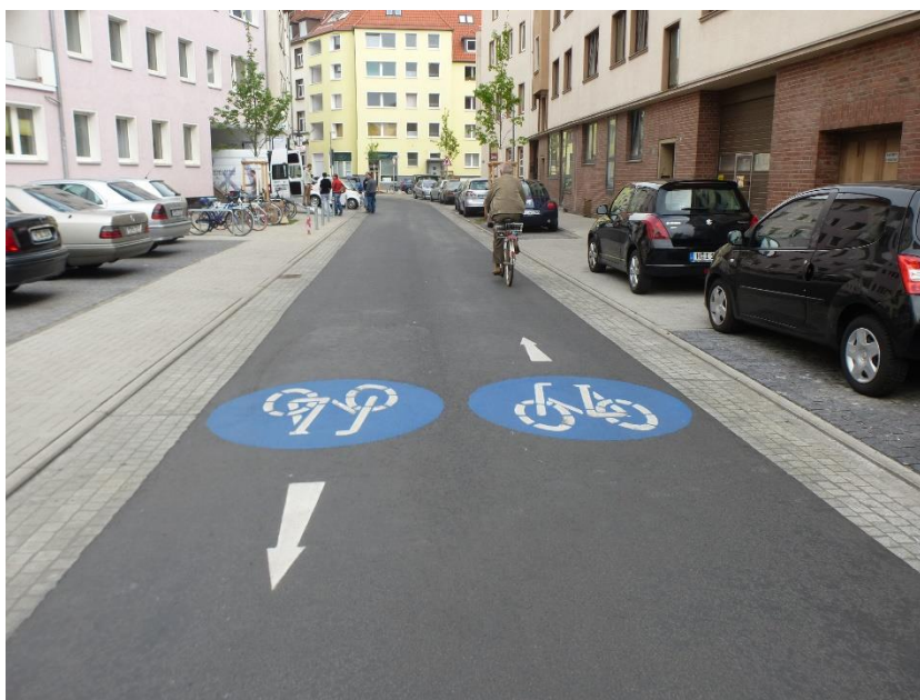
Abb. 59 Best practice Fahrradstraße mit optisch abgesetzten Fahrbahnseitenstreifen (Hannover, Große Barlinge)
