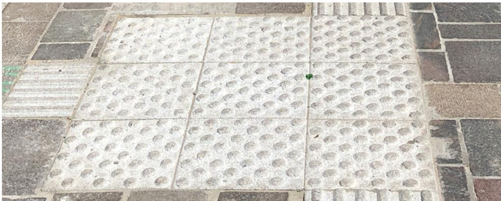
Abb. II 34 – diagonale Anordnung der Noppenstruktur auf Noppenplatten
