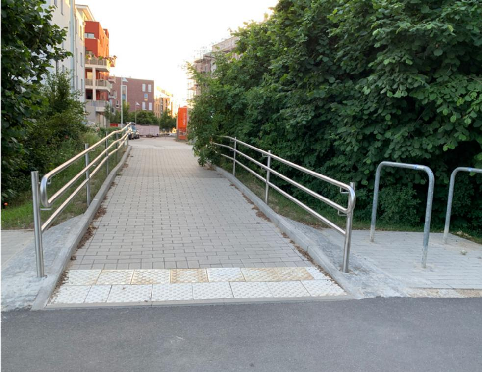
Abb. V 10 – Rampe mit farbigem Podest und Geländer
