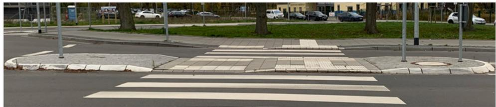
Wenn punktuell die einzuhaltenden Neigungsverhältnisse aufgrund der topographischen Gegebenheiten nicht umsetzbar sind, sollte dennoch eine Neigung von 12 % auf maximal 1 m Länge nicht überschritten werden.
