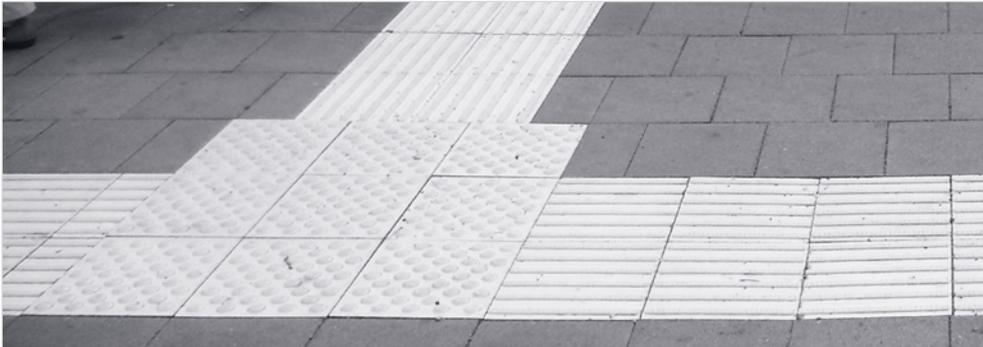
Abb. II 38 – Abzweigfeld an Ab- oder Verzweigungen von Leitstreifen
