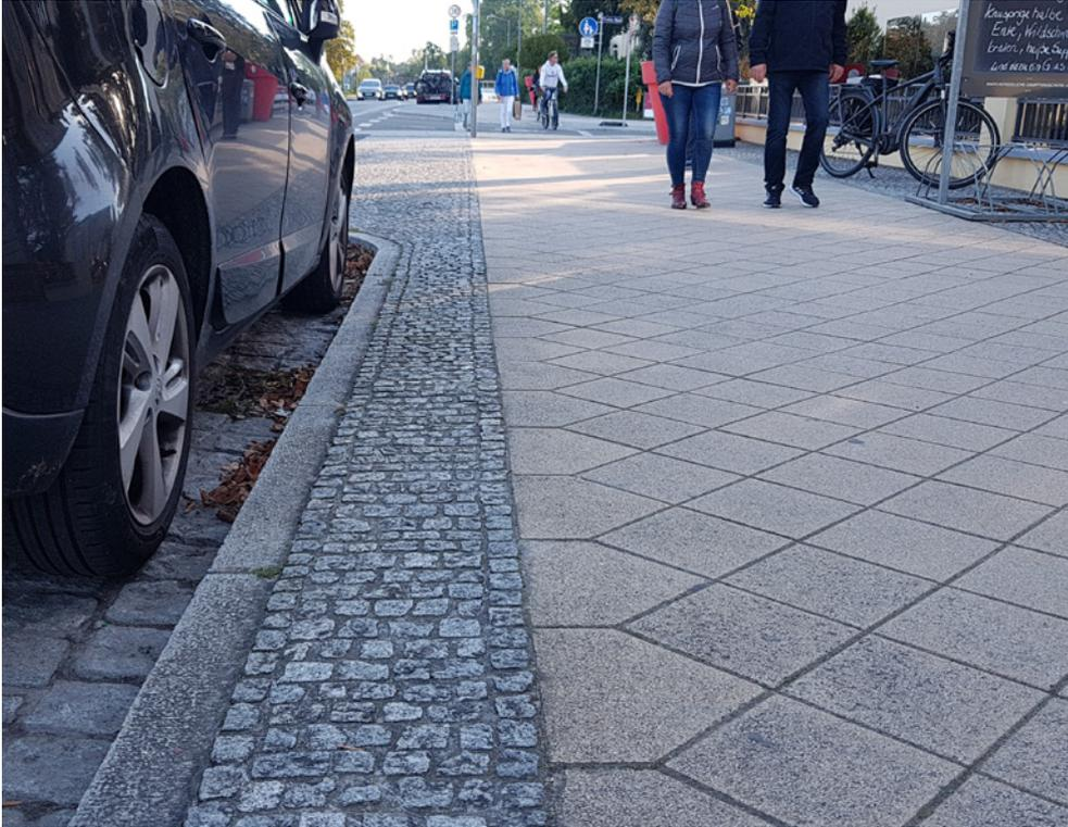
Abb. V 20 – Gehbahn, beidseitige Einfassung mit gut kontrastiertem Kleinpflaster
