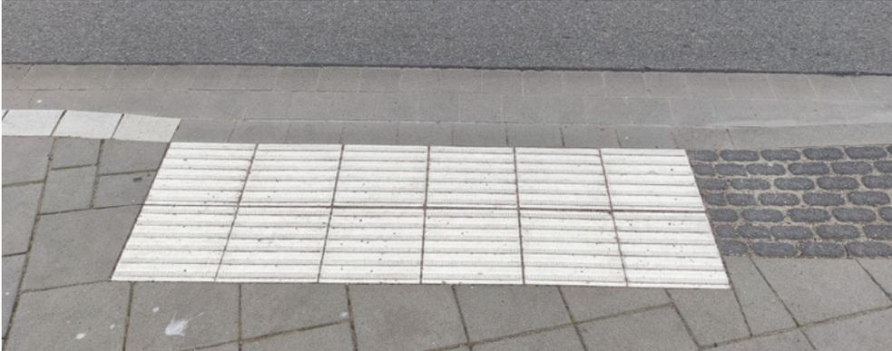
Abb. II 27 – Rippenplatten vor Querungsstelle mit Nullabsenkung (Sperrfeld)
