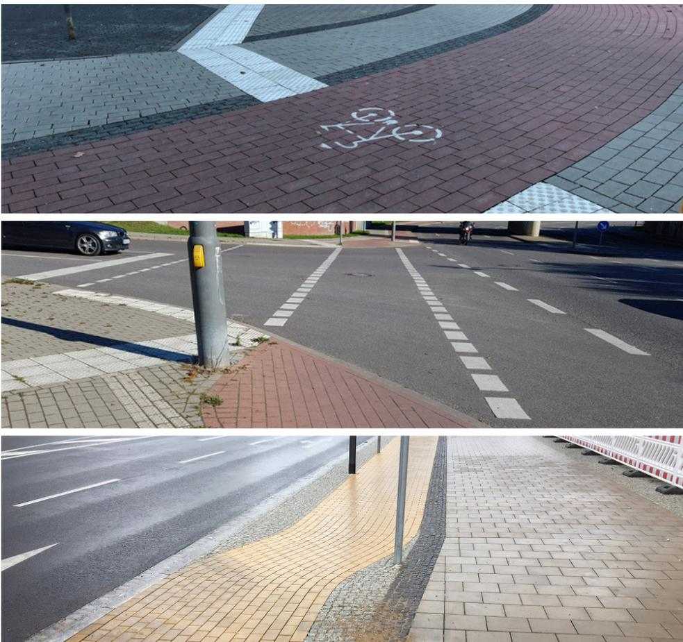
Abb. III 6 – Beispiele für Trennung von Geh- und Radwegen durch optisch und taktil kontrastierende Streifen
