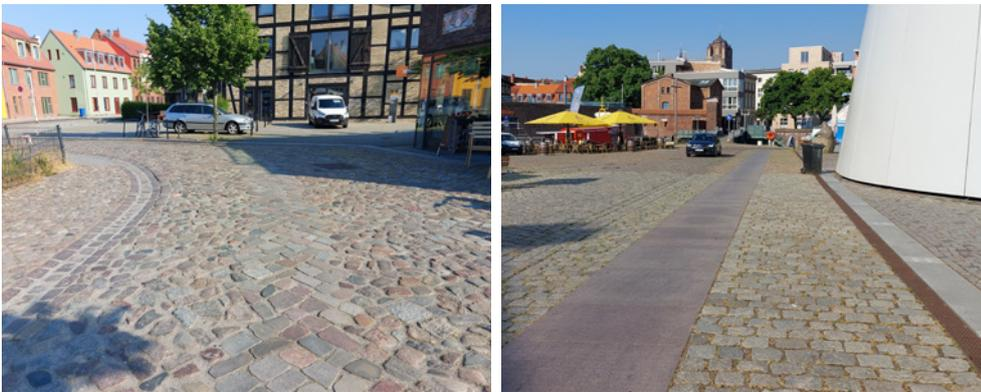
Abb. III 1 – Beispiele für Oberflächen aus Natursteinpflaster und -platten
