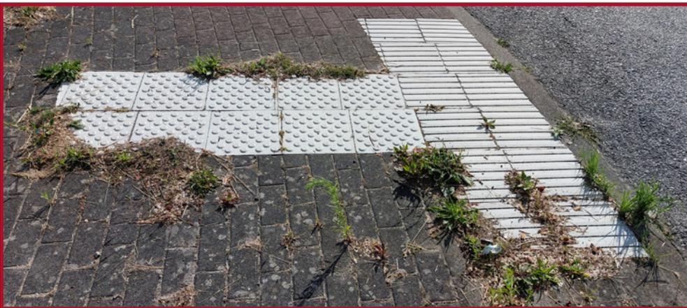
Abb. II 42 – eingeschränkte Nutzbarkeit von Bodenindikatoren durch fehlende Unterhaltung
