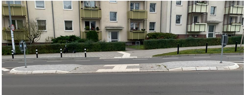
Bei getrennten Geh- und Radwegen ist an Kreuzungen und Überquerungsstellen die auf Fahrbahnniveau abgesenkte Radfahrerfurt grundsätzlich getrennt von der Führung des Gehweges mit entsprechender Einleitung der Querungsstelle mittels Bodenindikatoren anzulegen. Dabei sind die überrollbaren bzw. ertastbaren Kanten deutlich durch die unterschiedliche Absenkung auf 0 cm bzw. 6 cm zu differenzieren (siehe auch Beispiele in Musterlösungen Abschnitt IV).
