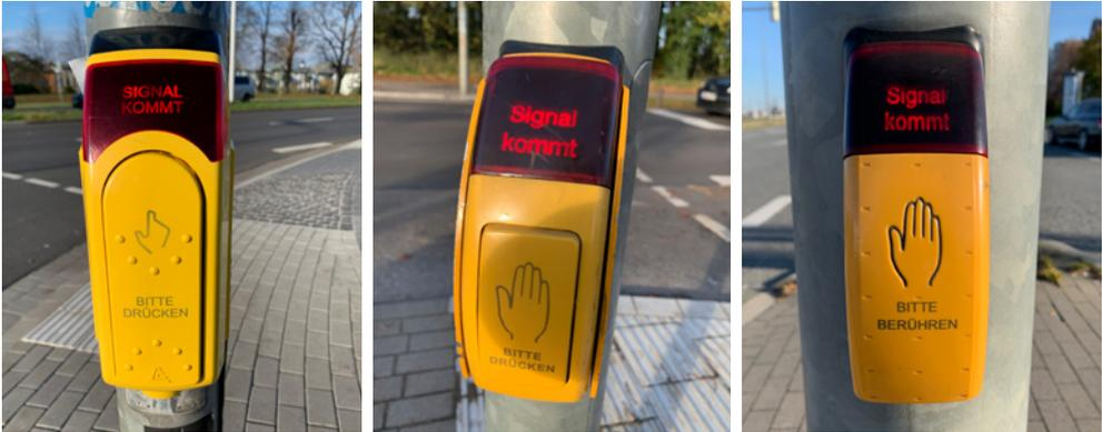
Abb. II 20 – Beispiele für Taster an LSA-Masten
