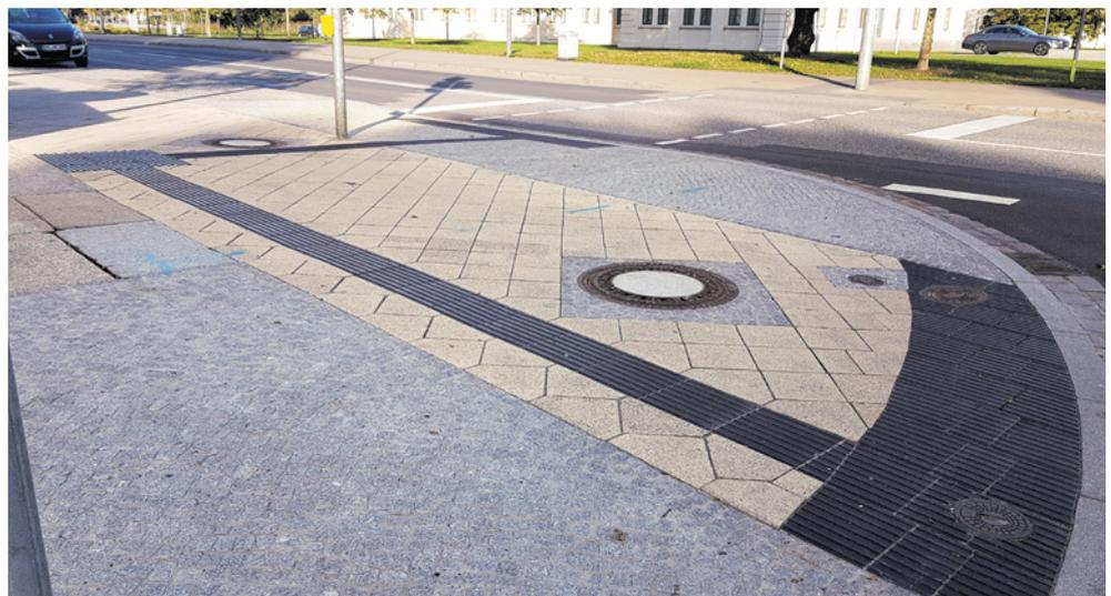
Der visuelle Leuchtdichtekontrast muss mindestens **über K 0,4** liegen (DIN 32975 [17]). „Das hellere Material der Materialkombination Bodenindikator und Begleitstreifen bzw. Bodenindikator und Umgebungsbelag muss einen Reflexionsgrad von mindestens 0,5 aufweisen.“ [19]
